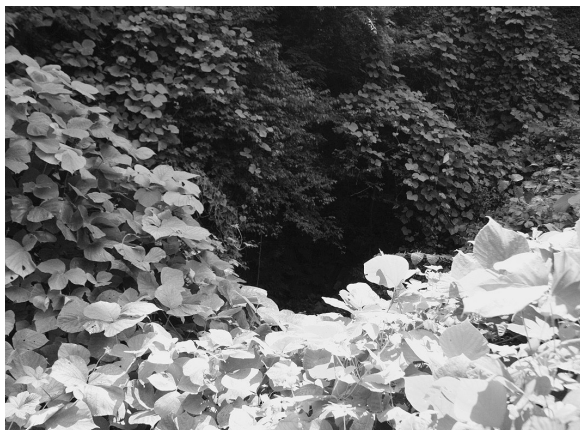
写真7 西墓地陥没箇所上部の坑道入口
