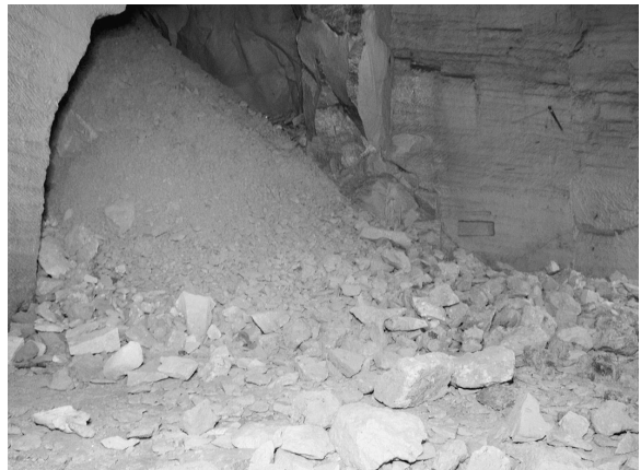
写真62 セツ尾口坑道内部に流れ込んだ陥没土砂
