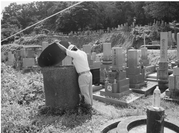
写真13 西墓地陥没部付近にあったセツ尾口坑道の通気口
