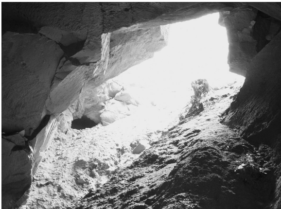
写真61 内部より見上げた破断口の拡大, 上部に小さな横坑入口が見える
