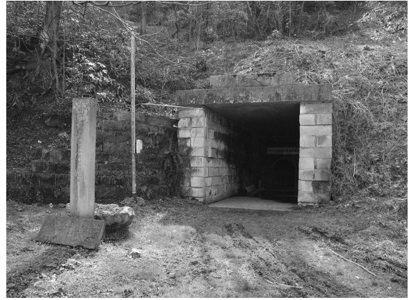
写真2 セツ尾口旧坑道入口
