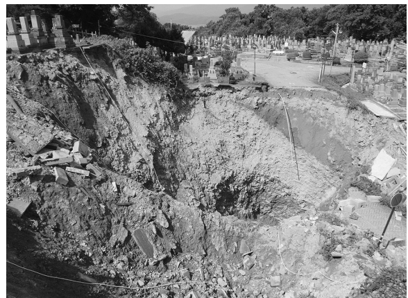
写真54 陥没地付近の様子
