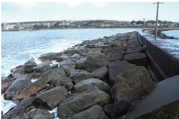
写真18：東尋坊の石材とわかる“エッセル堤”の岩積み
