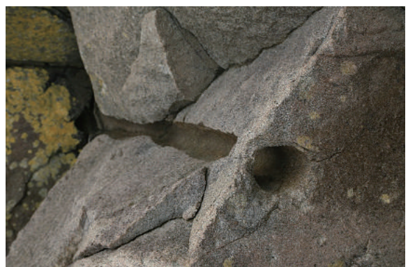
写真27：“七ツ岩”付近の直径25ミリのダイナマイト発破孔跡
