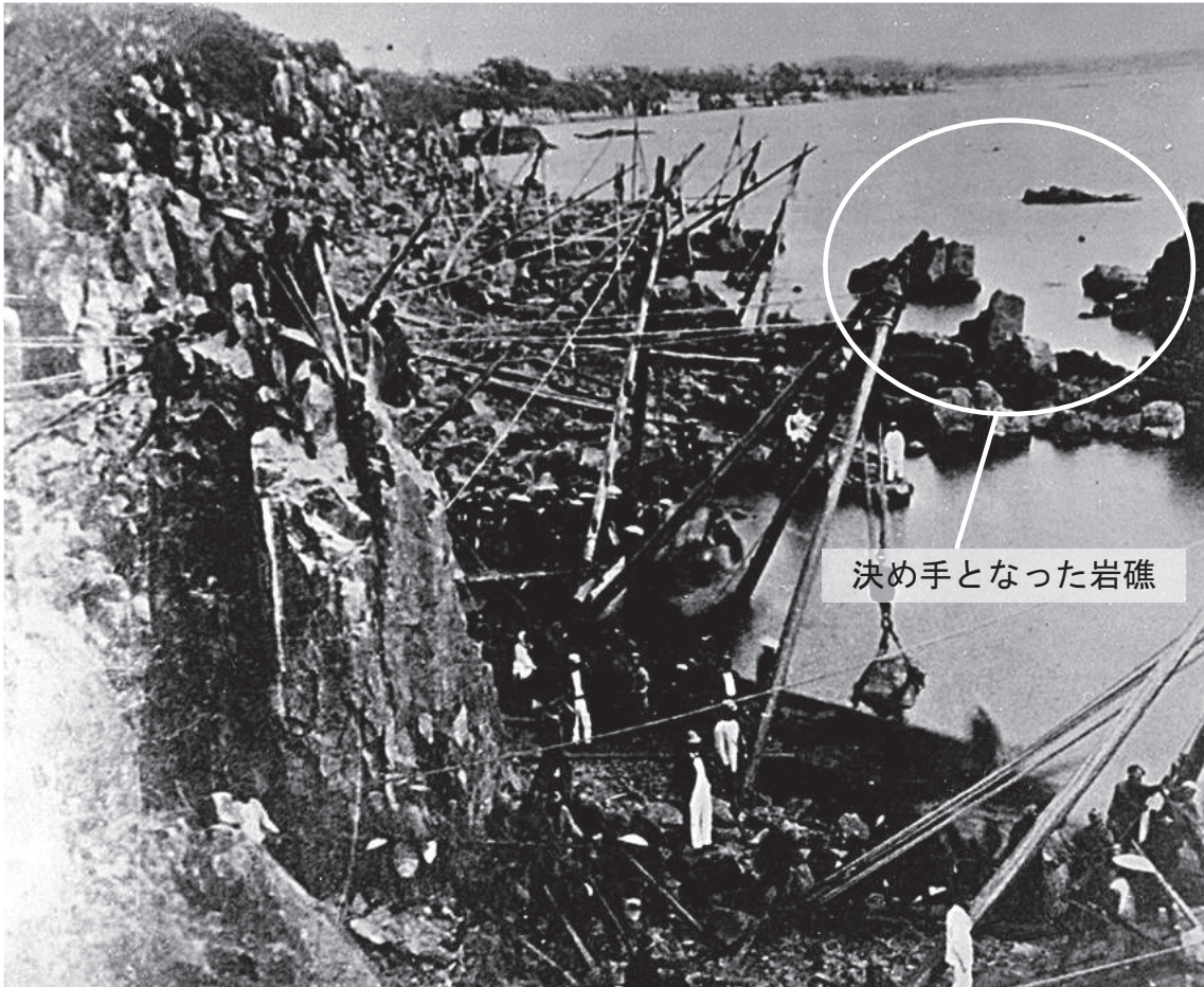
写真1：明治11年，東尋坊南部“七ツ岩”付近の石材採掘現場記録写真（みくに龍翔館提供）
