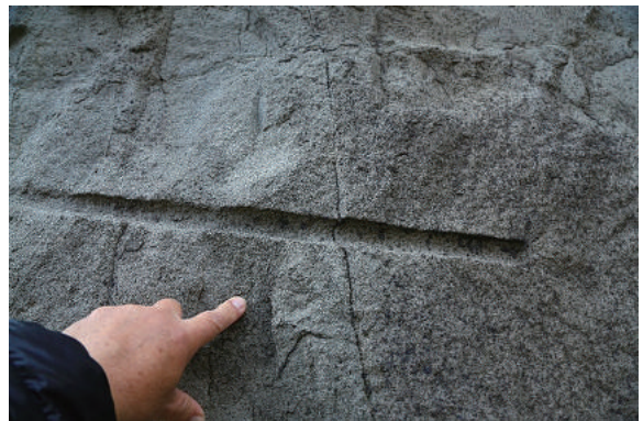
写真25：“千丈敷”壁面のハーフパイプ状のダイナマイト発破孔跡
