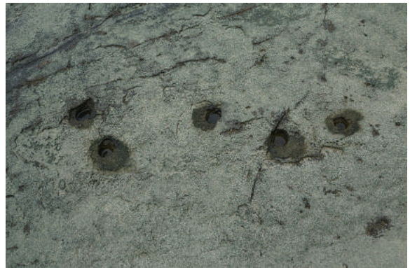
写真23：“千丈敷”の密集したダイナマイトを装填する発破孔跡
