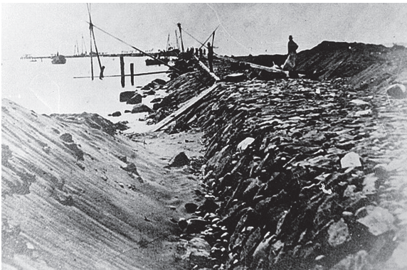
写真10：明治12年、建設中の“エッセル堤”（みくに龍翔館提供）
