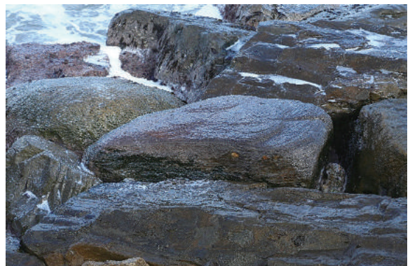
写真19：“エッセル堤”で見られる雄島の石材（中央）
