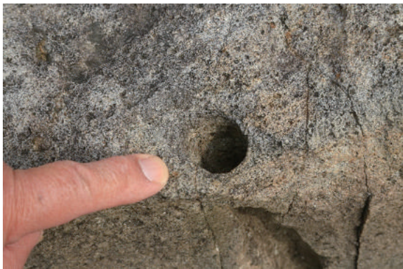
写真24：“七ツ岩”付近のダイナマイト発破孔跡
