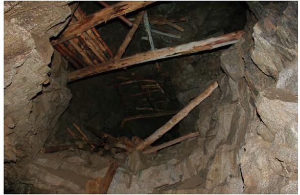
写真10：3階部への斜坑。2階部を渡る橋が残る。
