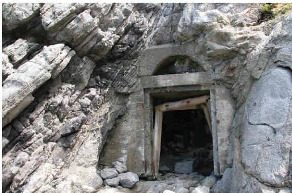
写真5：2号坑西口は超丹波帯（左）と角閃石黒雲母花崗岩との接触部に沿って掘られている。
