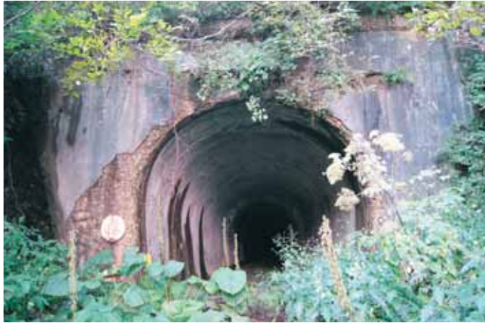
図1：谷トンネル坑口 (2010年10月18日)
