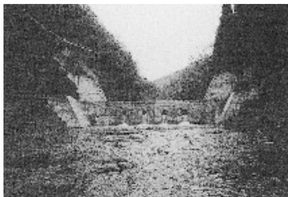
笹生川堰堤（昭和61年12月完成）
