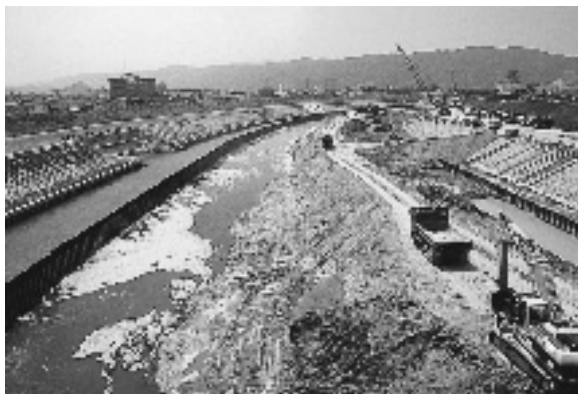
写真1 工事中の新明里橋下流域
