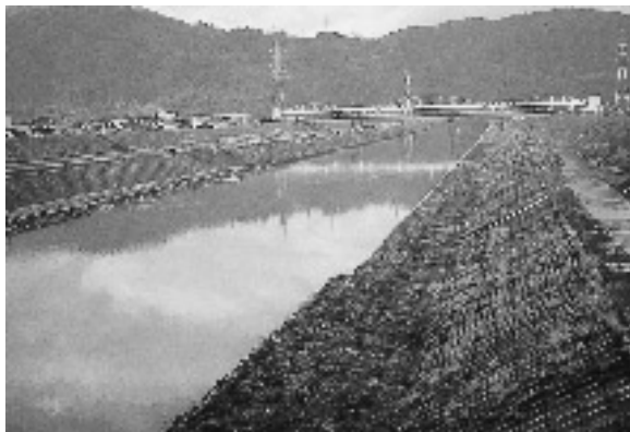
写真3 開放水面になった工事後の水越橋下流域
