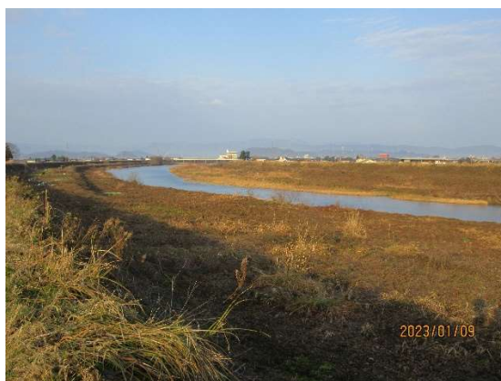
図2：毘沙門橋下流（2023年1月9日撮影）
